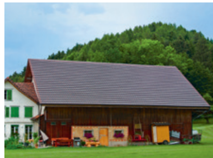
Ausschnitt Dachfläche mit Solarziegeln:
