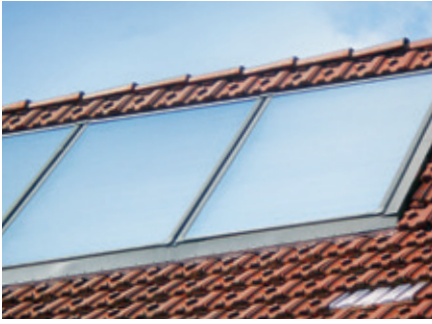
Thermische Sonnenkollektoranlage
