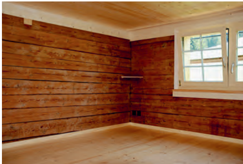
Innenansicht 1 nach der Sanierung: Strickwand sichtbar, Aussendämmung in Hohlraum des ehemaligen Zugladers
