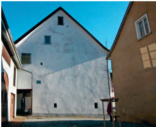
Nordfassade vor der Sanierung
