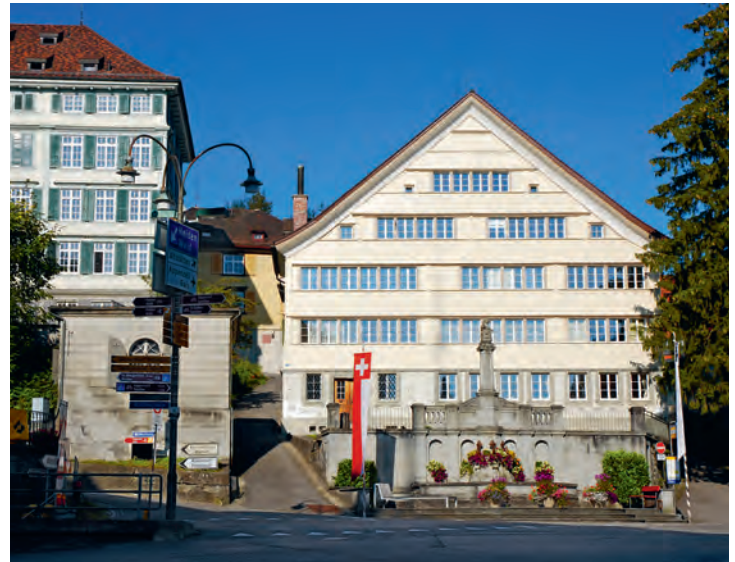
Ostfassade nach der Sanierung, neue Fenster ohne vertikaler Sprosse
