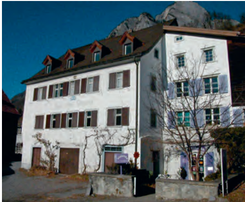
Südfassade vor der Sanierung
