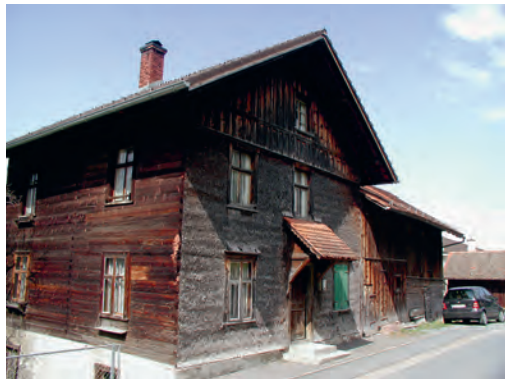
Gebäude vor der Sanierung
