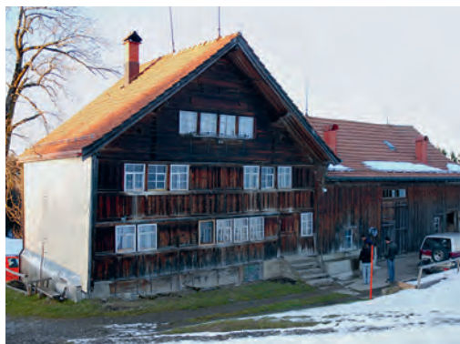
Südfassade vor der Sanierung
