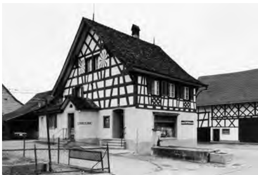
Gebäude vor der Sanierung
