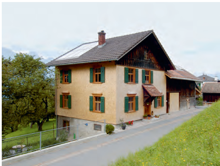
Nach der Sanierung: Die erneuerte Gebäudehülle schützt das Denkmal nachhaltig. Die noch helle Schindelfassade wird mit der Zeit nachdunkeln.
