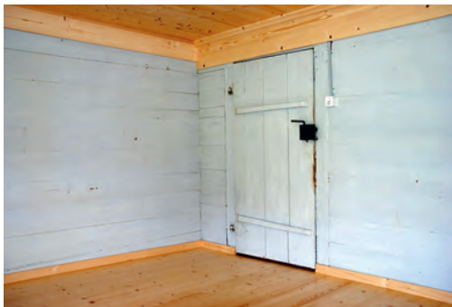
Innenansicht 2: Sichtbare Anschlussarbeiten an die erhöhte Decke
