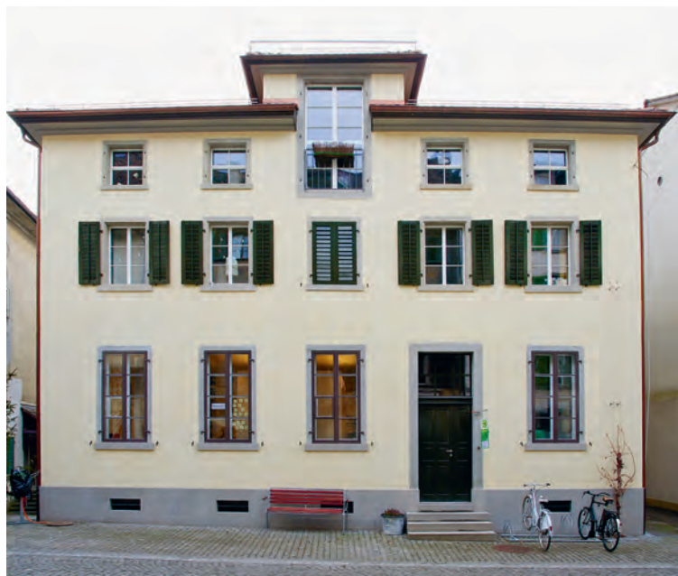
Nordfassade nach der Sanierung
