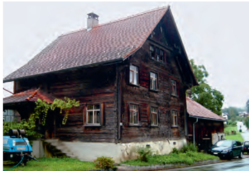
Gebäude vor der Sanierung
