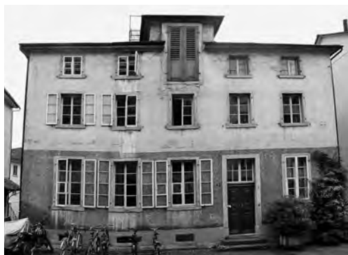
Nordfassade vor der Sanierung
