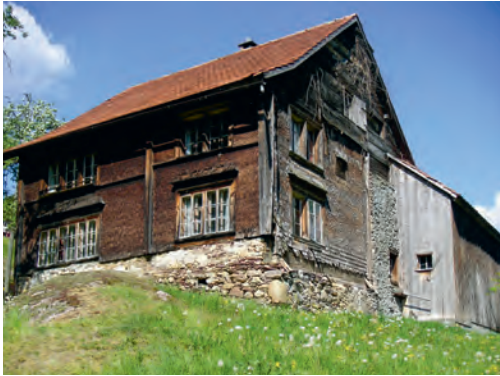
Nord- und Ostfassade vor der Sanierung
